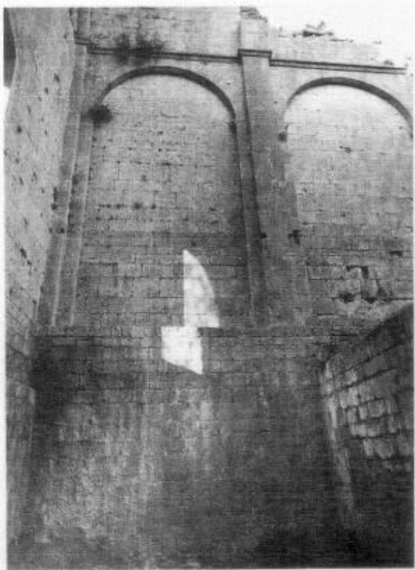
FIG. 7. — INTÉRIEUR DE LA TRAVÉE OCCIDENTALE, CÔTÉ NORD
